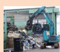
マルチ解体機での解体
