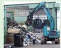
マルチ解体機での解体
